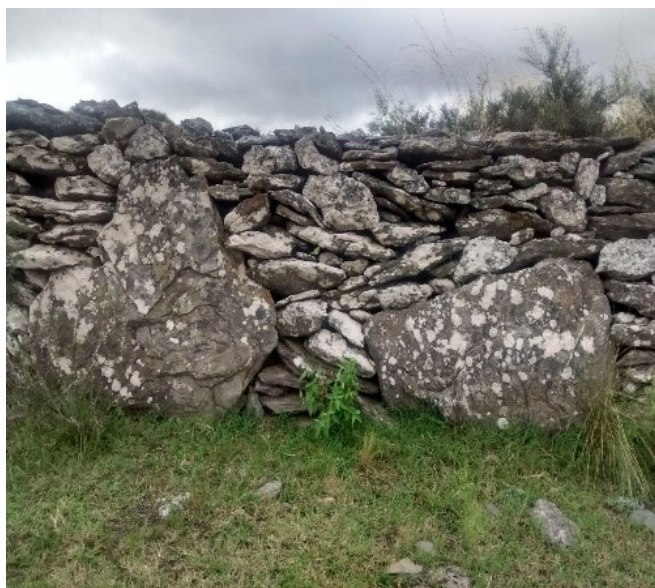
Figura 9. Pircados cerca al puesto de Oca. Se observan sus fuertes bases. Fotografía de la autora (2017).
