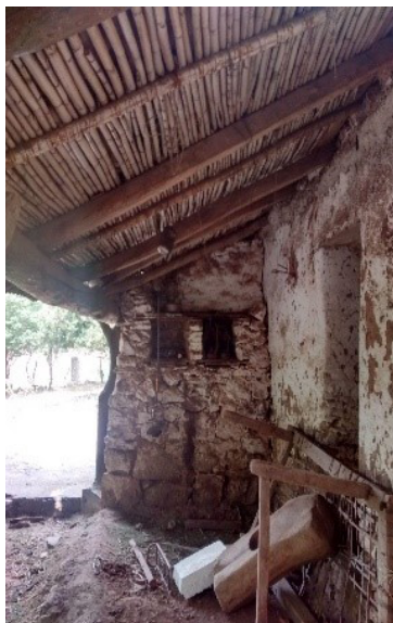
Figura 6. Galería techada en el puesto de Pantanillo. Se observa la cubierta de peinado amarrada a las vigas de madera y de hornacinas en uno de los muros laterales. Fotografía de autora (2017).
