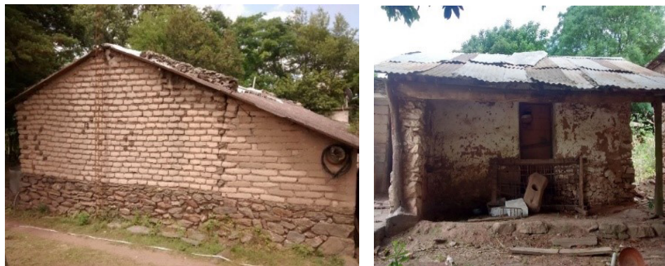
Figura 4. a) Vista lateral al puesto de Oca. Se observa su muro de adobes sobre una base de lajas y esquistos. b) Vista frontal al puesto de Pantanillo. Se observan sus muros revestidos en mortero de barro y cal y su base de lajas y esquistos. Fotografía de autora (2017).
