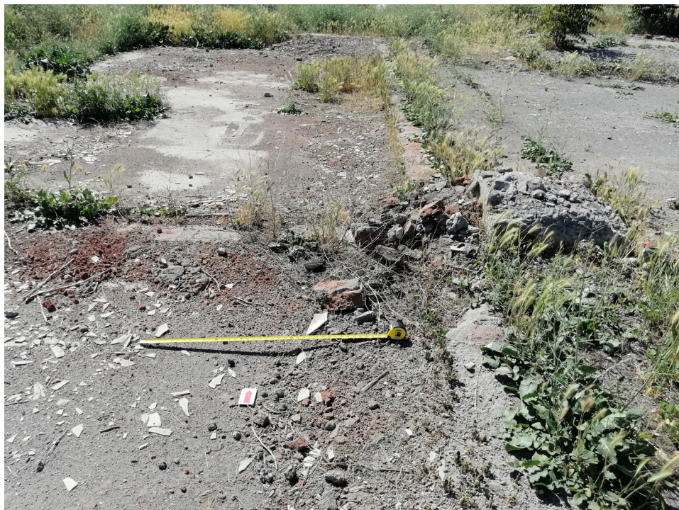
Figura 8. Vista general del piso y los muros internos de la carpintería.
