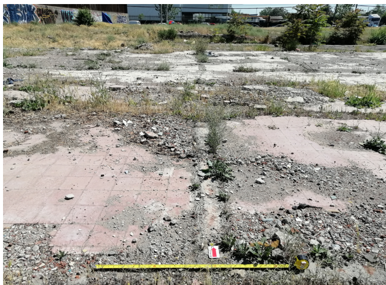
Figura 10. Vista General de la Edificación 01. Se observan muros interiores, pisos de cemento y detalles en cerámica.
