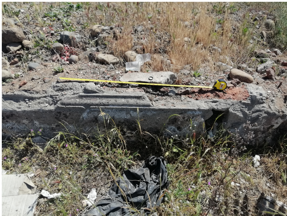
Figura 7. Muro externo de la enfermería. Se observan detalles de mampostería y pintura.
