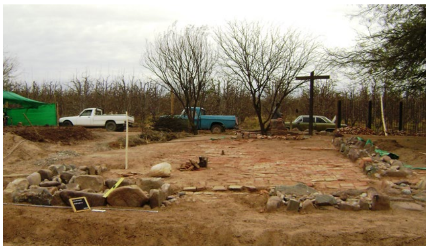
Figura 15. Tareas de recomposición de los cimientos originales de la capilla.
