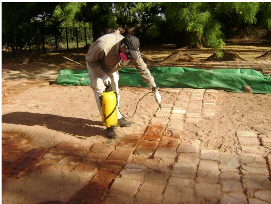
Figura 14. Implementación del tratamiento químico para la preservación y conservación.
