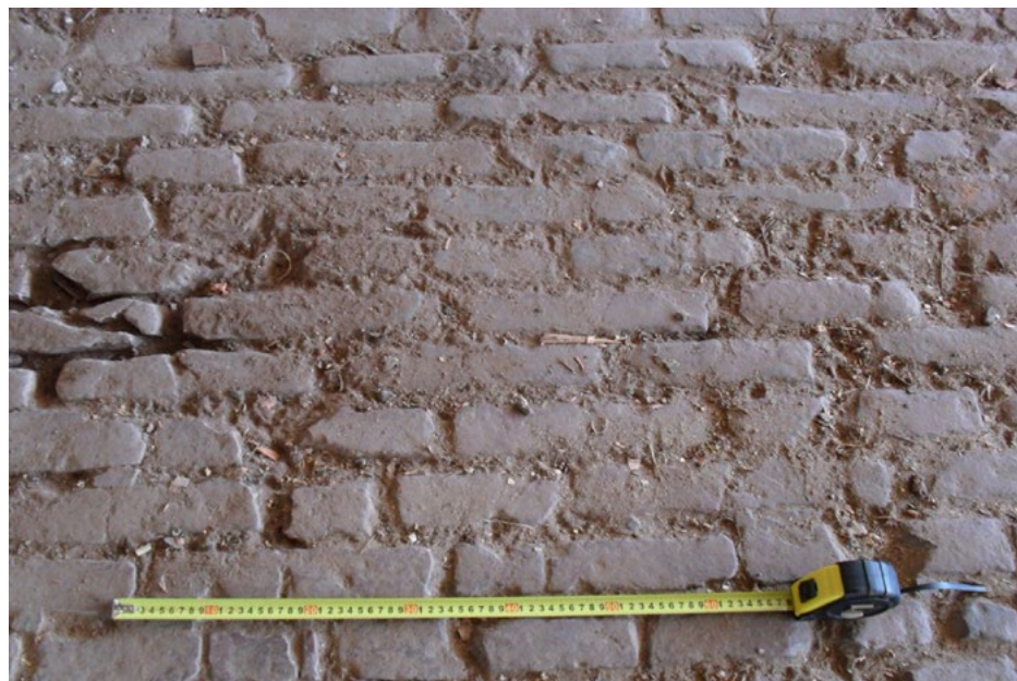
Figura 6. Piso de ladrillo registrado en carpintería.
